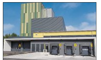
Blick in die Lagerhalle. Der neue Baukomplex.
