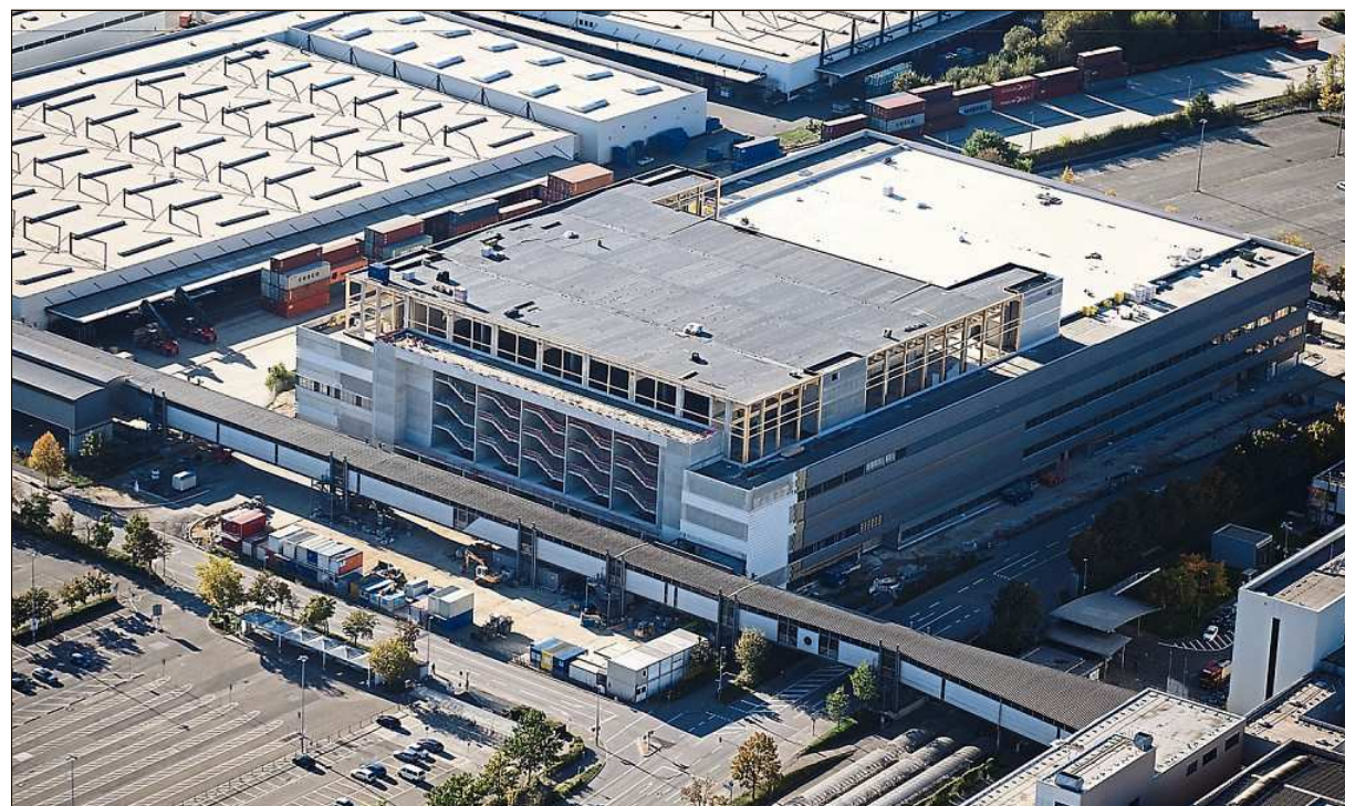
Die neue Halle B im GVZ Ingolstadt aus der Luft gesehen.
